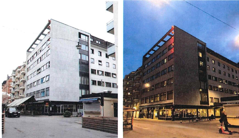
Bilden visar fastigheten Guldfisken 26 sedd från nordöst på Nybrogatan. Gavelfasad klädd i gråvita marmorplattor och takets karaktäristiska öppna ramverk som avslut mot himlen, visas som dag och kvällsbild. Bild: Nyréns.
