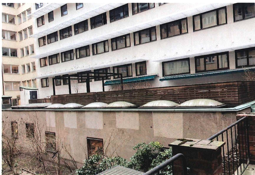
Bilden visar delar av fasad och underbyggt gårdsbjälklag för kvarteret Guldfisken 26, sedd från Guldfisken 3. Bild: Stadsbyggnadskontoret
